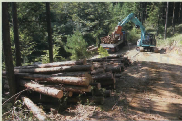
作業道の支障木を搬出。グラップルから直接トラックに積み込むことにより作業効率の向上が図られる。
